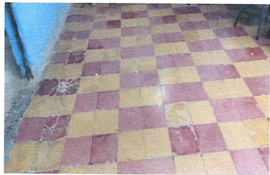
Foto 4: Cambio de Piso deteriorado
